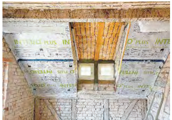
Dämmung der Dachflächen
