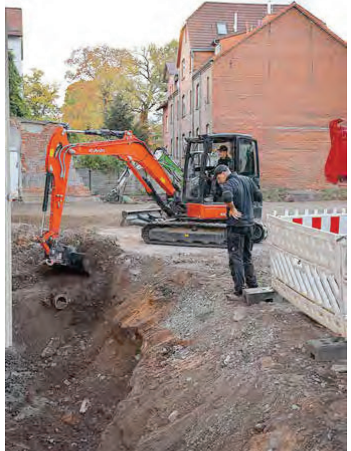
Sockelarbeiten auf der Baustelle der Theaterwerkstatt im Oktober 2022.
