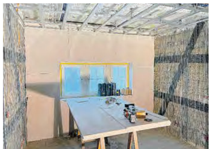
... und Einbau Trockenbauverkleidung
