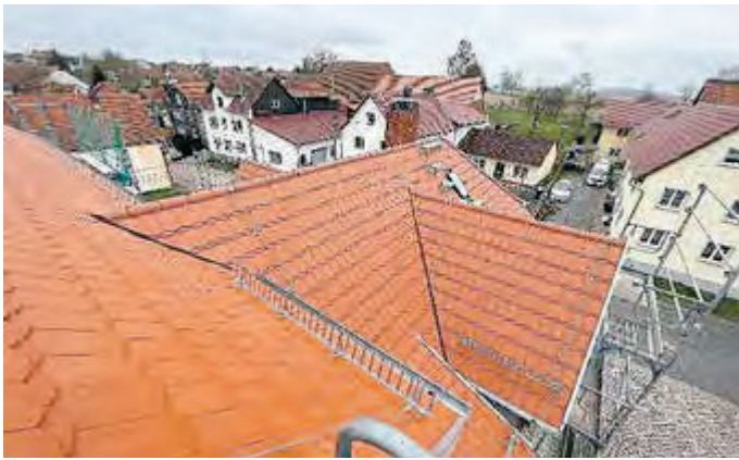
... und Rückbau der Dacheindeckung sowie sanierte Dachfläche des ehem. Lehrerwohnhauses
