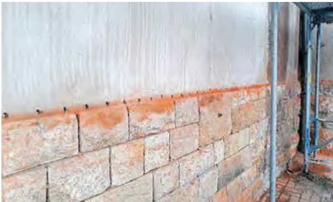
Nachträgliche Horizontalabdichtung der Außenwände im Injektionsverfahren
