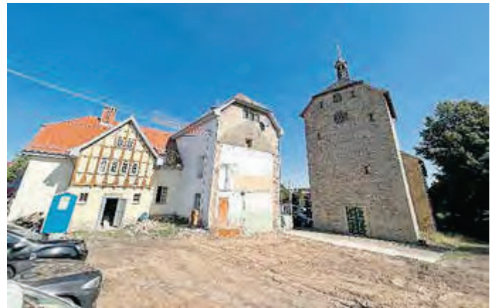
... sowie freigestellte Sicht auf Kirchengebäude nach Abbrucharbeiten
