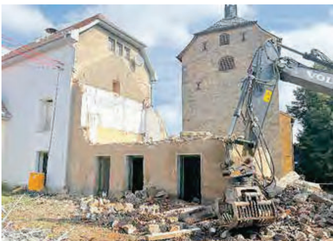
Abbruch seitlicher Anbau
