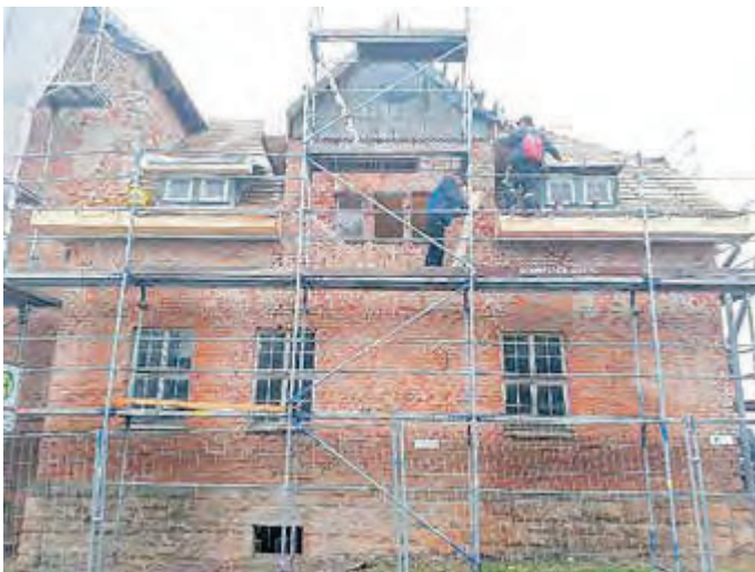
... sowie freigelegtes Außenmauerwerk
