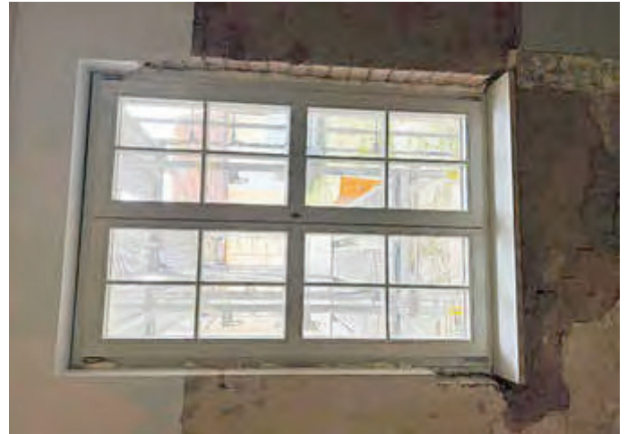
Saniertes Fenster mit historischer Glasteilung und neuem Fensterbrett
